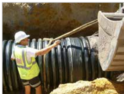
Bei ungeformter Muffe immer über das Innenrohr Kraft ausüben
