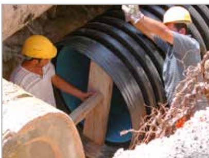
Bei ungeformter Muffe immer über das Innenrohr Kraft ausüben
